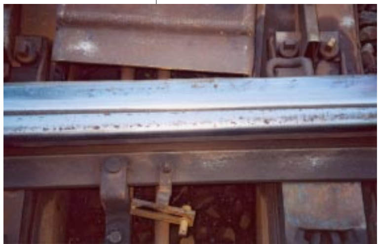
Bild 10: Schleifen von Schienen in Weichen
