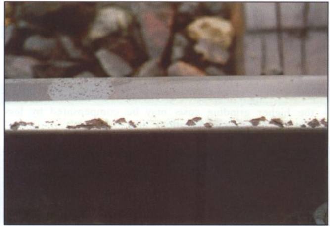
b: spalling
