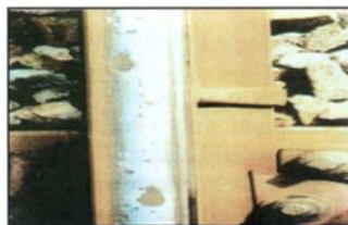
Fig. 9: Ballast marks
