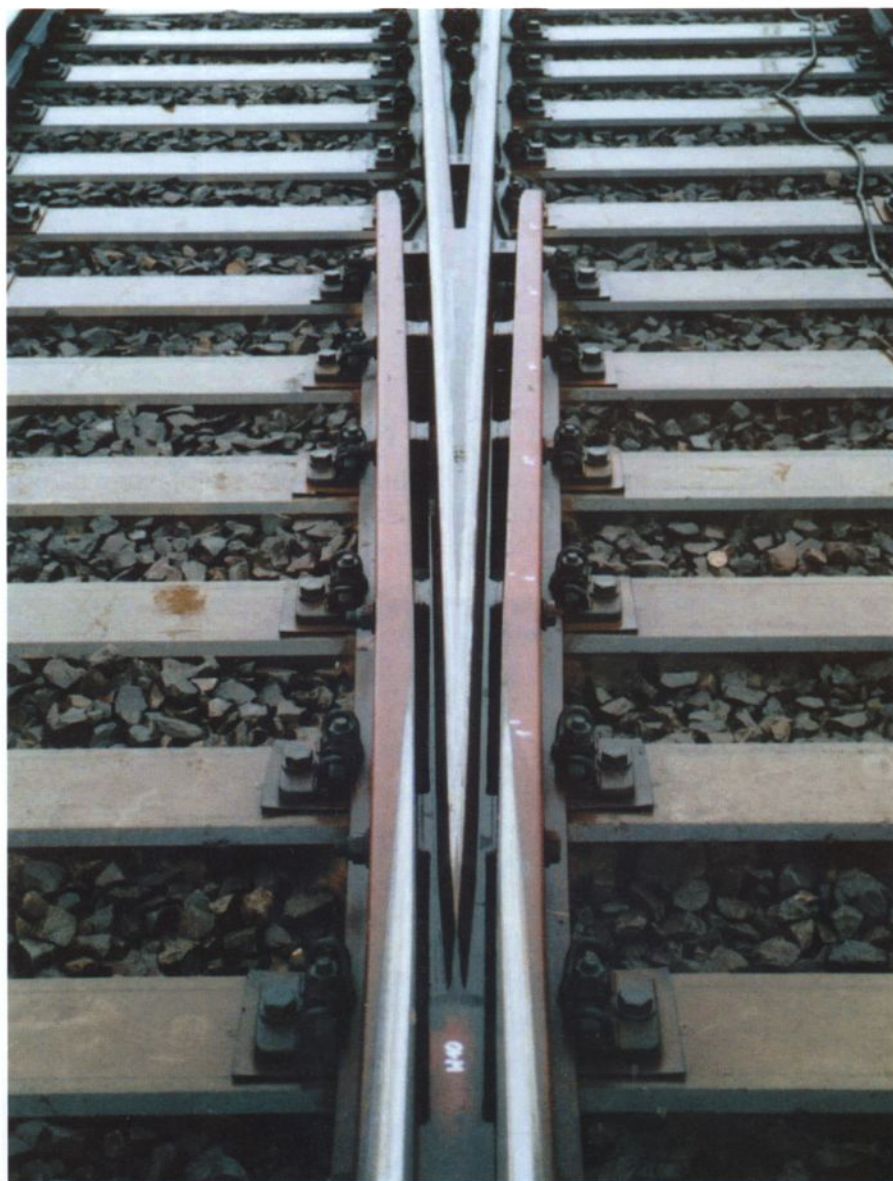
Fig. 2 - Cœur de voie conventionnel
