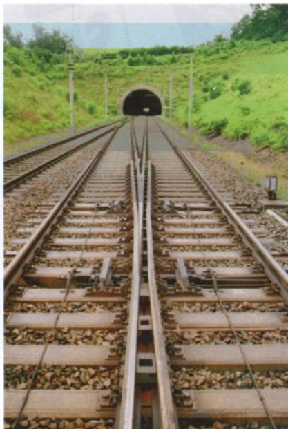
Fig. 1 - Cœur de voie à pointe mobile
