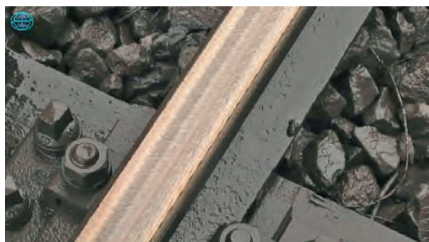
Bild 7: Fertig bearbeitete Schiene in einer Weiche
