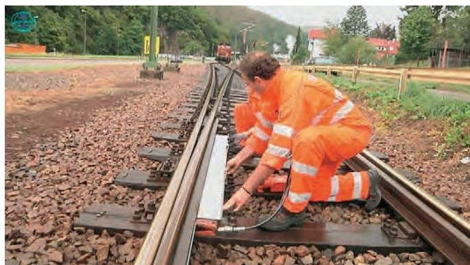
Bild 6: Anheben der Weichenzunge vor dem Schleifen
