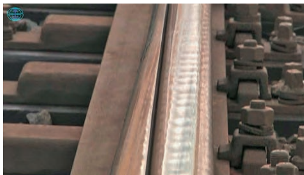
Bild 3: Verriffelung auf einer Backenschiene
