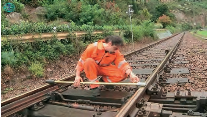
Bild 9: Überprüfung des Verschleißvorrats mit Lehre 1
