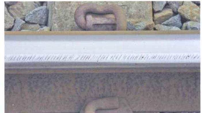
Abb. 7: Headchecks an der Fahrkante
