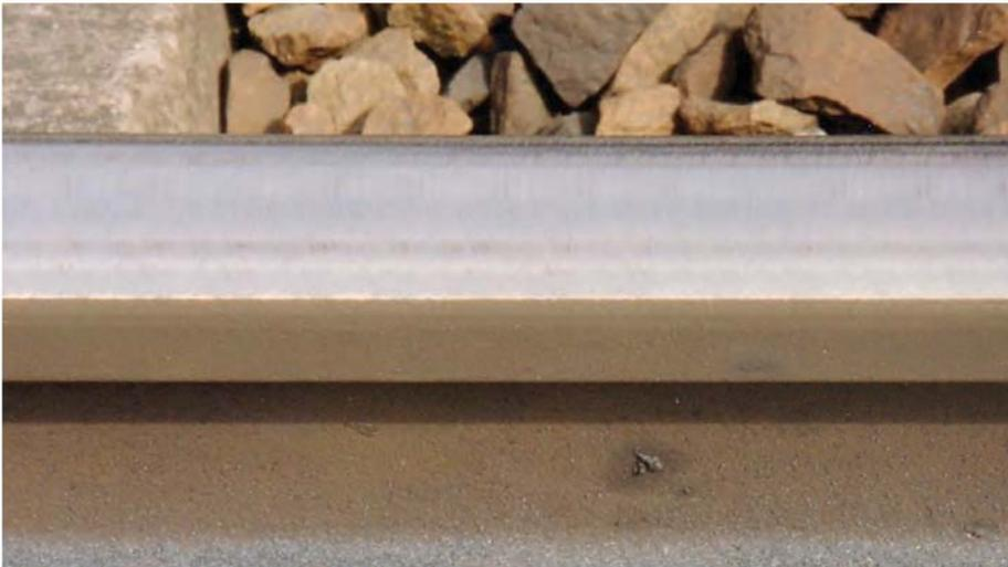
Abb. 6: Geschliffene Schiene – feines (akustisches) Finish
