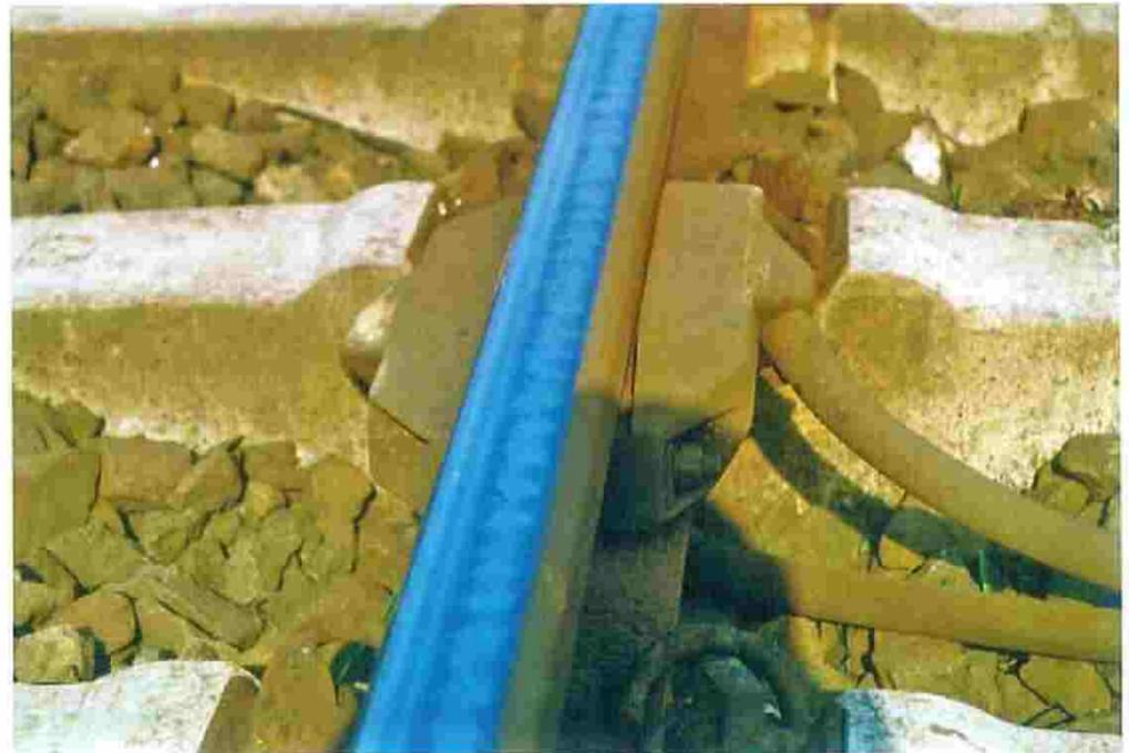
Bild 1: Verriffelung (im Bereich eines Gleiskontakts)
